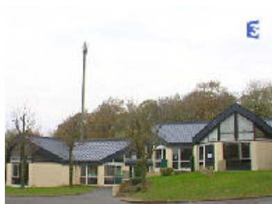
Antenne relais SFR à quelques mètres des écoles maternelle et primaire de Ruitz (Pas-de-Calais) - F3 NPDCP
